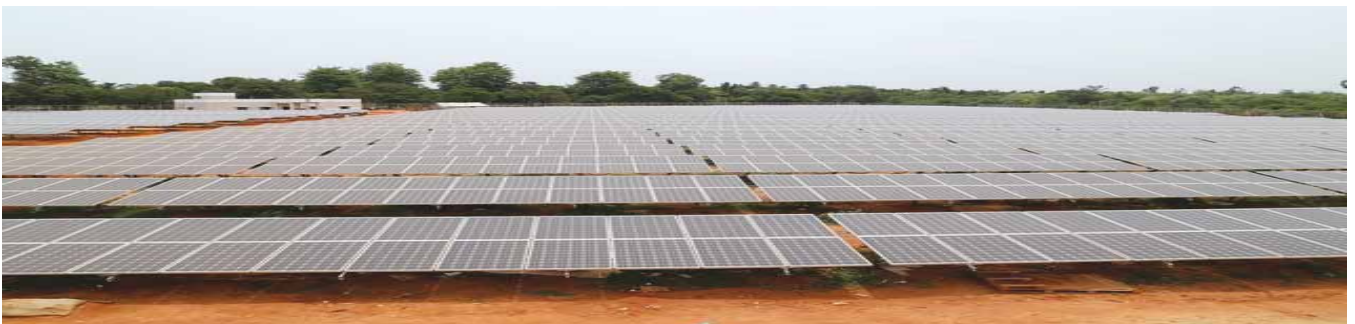
चित्र: नेयवेली टाउनशिप ब्लॉक -4 में फ्लैट पैनल मल्टी/ पॉली क्रिस्टलीय सिलिकॉन पीवी सेल प्रौद्योगिकी
