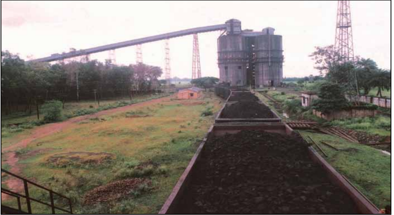
आटो वैगन लोडिंग सिस्टम के माध्यम से उपभोक्ताओं को कोयले का प्रेषण
